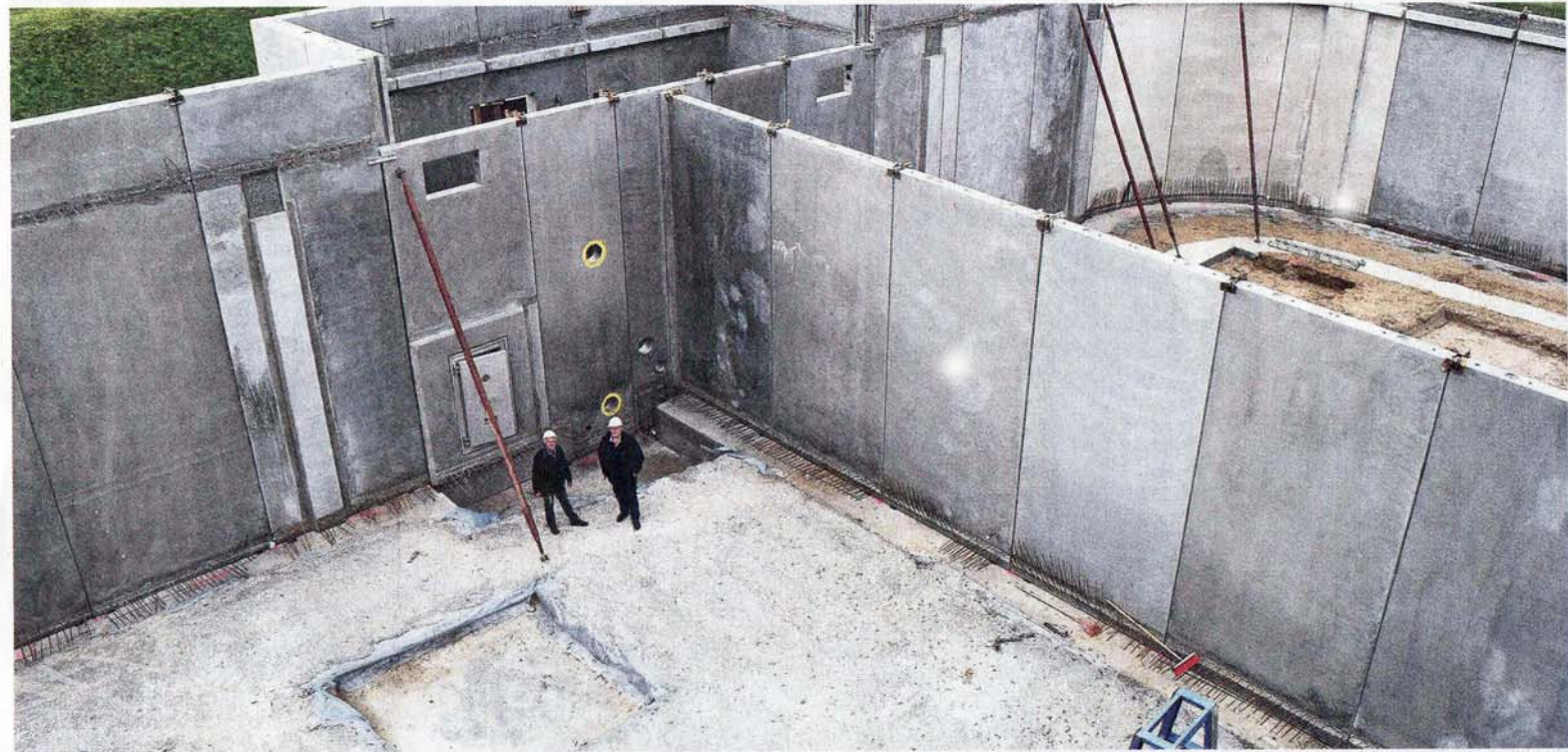
Ein mächtiges Bauwerk entsteht in Krumbek: Den Reinwasserbehälter, der eine sichere Vorratshaltung gewährleisten soll, baut der Wasserbeschaffungsverband Panker-Giekau für 32 Mitgliedsgemeinden. FOTOS: ASTRID SCHMIDT
